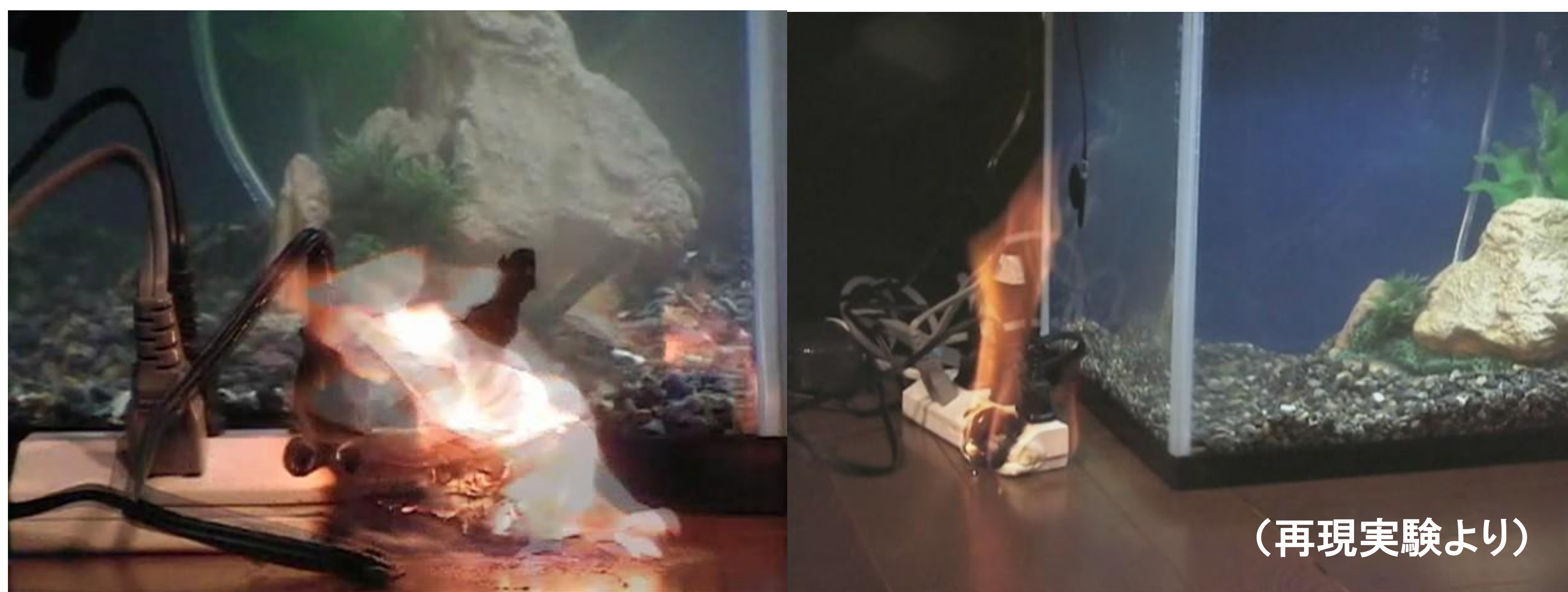
水がかかり発火する水槽用器具を接続したテーブルタップ
